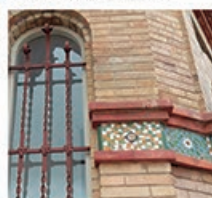
Estació de l'antic tramvia ● Estación del antiguo tranvía The old tram station Gare de l'ancien tramway ● Isaac Albèiz, 14
