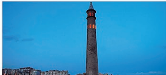
7 Torre d'Aigües del Cros. 1900 Torre/Tower/Tour Josep Puig i Cadafalch Av. Molí de les Mateves, s/n
